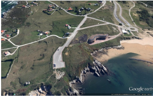
Vista aérea desde el oeste. Estado actual.
